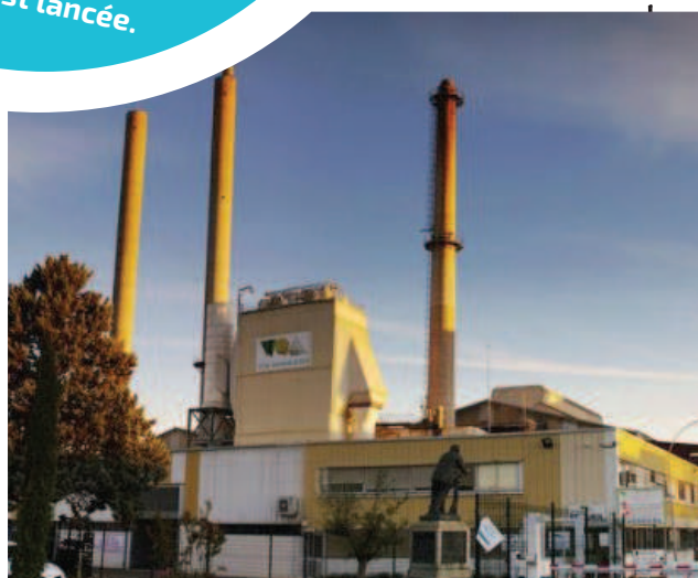
Exemple d'Écologie Industrielle Territoriale : Partenariat entre Trifyl et les verreries locales
